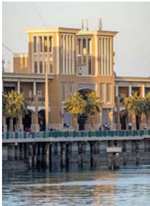
'Sharq' Alışveriş Merkezi'nin dekoratif rüzgar kuleleri.
